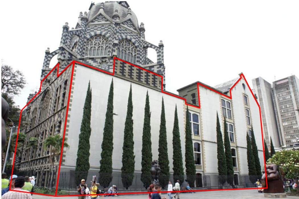
Figura 1. Fachadas norte y occidente del Palacio de la Cultura Rafael Uribe Uribe, remarcadas las superficies a intervenir
